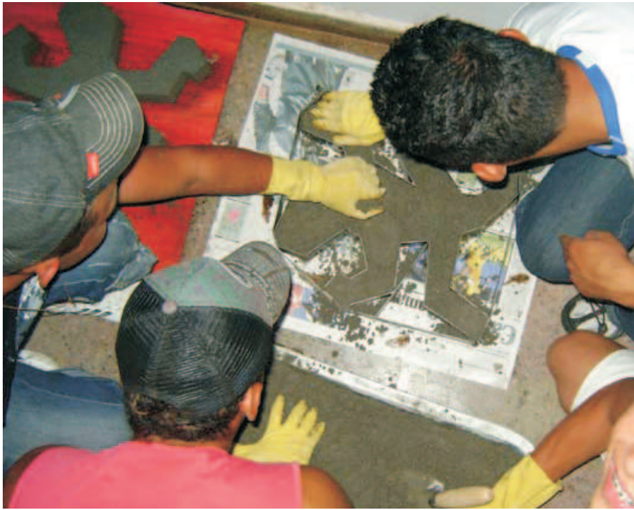
Figura 8.4 Enchendo a forma de concreto
